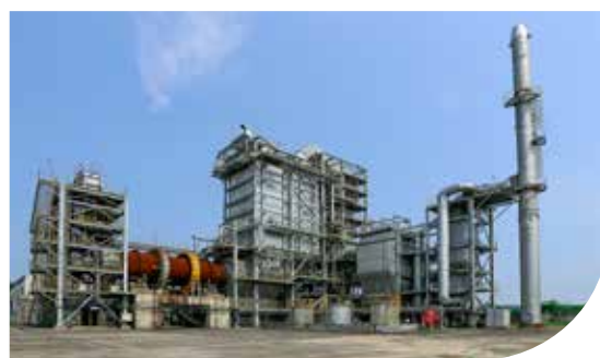
Nhà máy đốt rác công nghiệp phát điện Nedo
